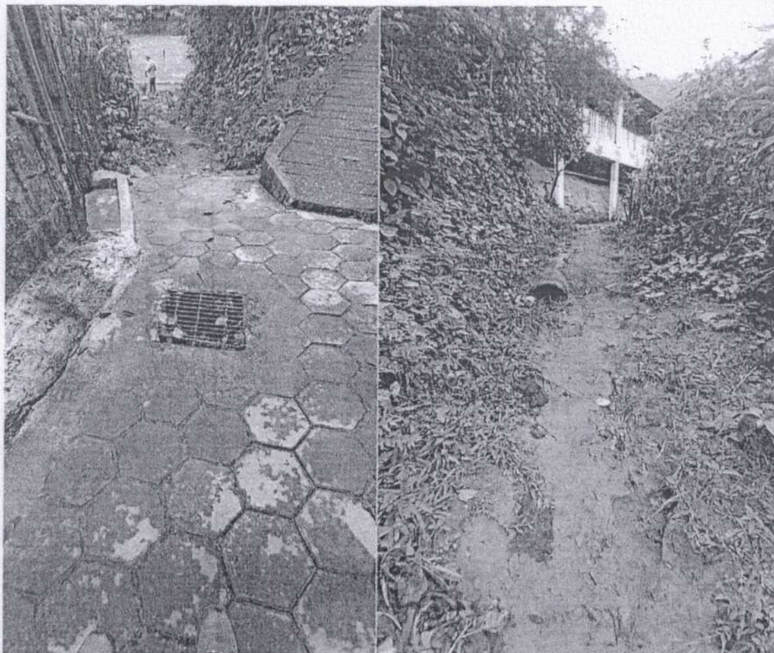
Imagem 04 – Vuelas sanitárias e de acesso – Rua paralela direita interna até o campo.
