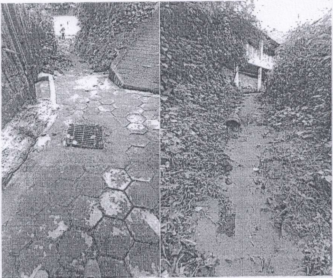
Imagem 04 – Vuelas sanitárias e de acesso – Rua paralela direita interna até o campo.
